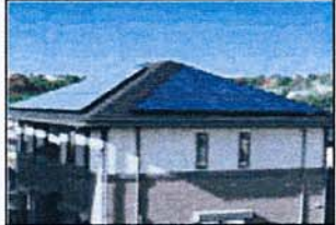
太陽光発電システム
